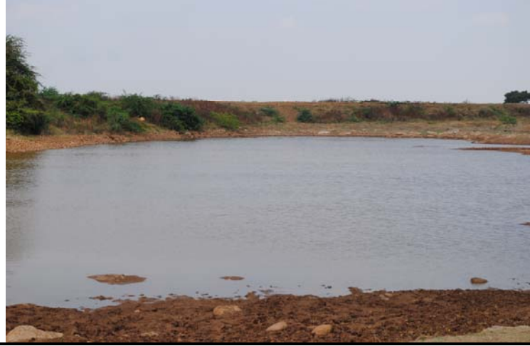
सलग समतल चर खोदाईमुळे पाजर तलावात साठलेले पाणी ...
